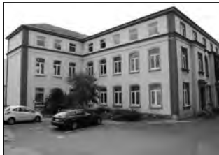
Altes Verwaltungsgebäude (AVG), Fabrikzeile 21, Hof
